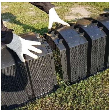
8. Połączyć tunele
